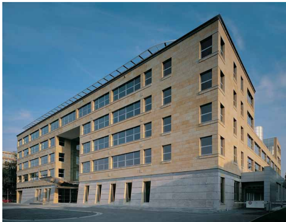
Centrala BPH w Krakowie przekształcona w Centrum Biurowe Lubicz, 1994-96
